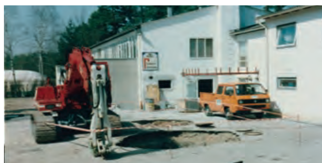
die alten Klärbecken werden verfüllt
