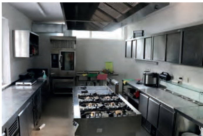
Vom Einbau des ersten neuen Küchenteils zur (fast) fertigen Küche
