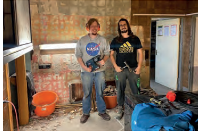
Die neuen Wirtsleute - hier als Abbrucharbeiter unterwegs ☺
